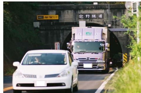
建築限界が不足するトンネル (H19.5 宅野トンネル)
