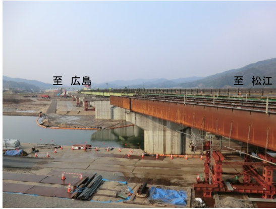
里方大橋付近 広島方面を望む
