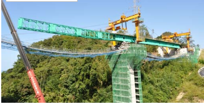
上部工施工中
