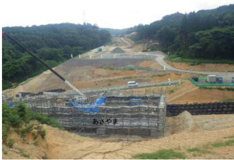
工事現場の状況（朝山地区改良第10工事）
