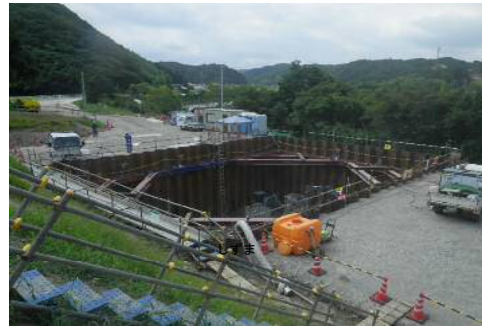
工事現場の状況（静間川橋下部第2工事）
