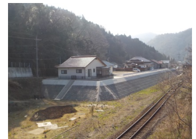
宅地嵩上げ整備箇所(松川橋付近)
