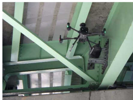
■新技術(UAV)による橋梁点検
