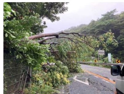
台風による被災状況 (令和3年8月8日 島根県大田市温泉津町地内)
