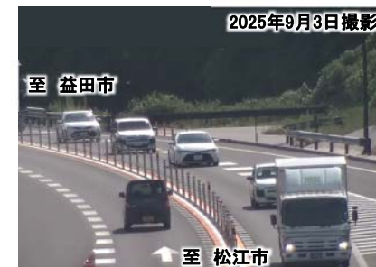
写真② 静間・仁摩道路利用状況
