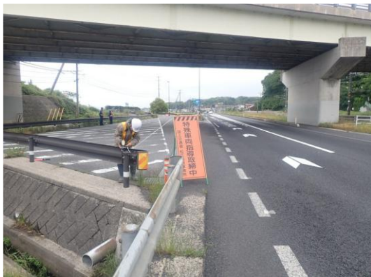
車両高さ計測状況
