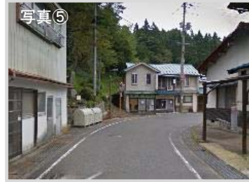
写真⑤ カーブ連続区間 見通しの悪い区間
