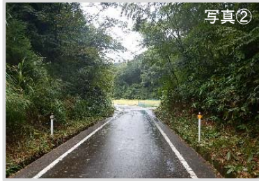
写真② 繁茂した植栽区間 急勾配
