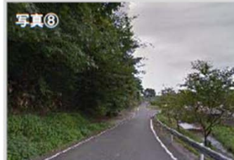
狭隘区間 植栽繁茂
