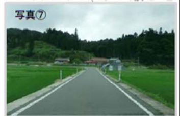
狭隘区間 単調区間
