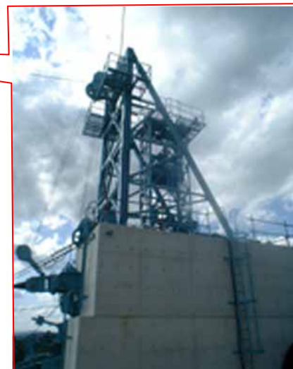
コンクリート打設用 ケーブルクレーン
