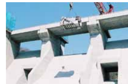
灰塚ダム建設工事の状況
