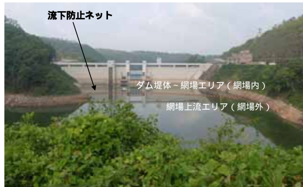
【流下防止ネットの位置と設置状況】
