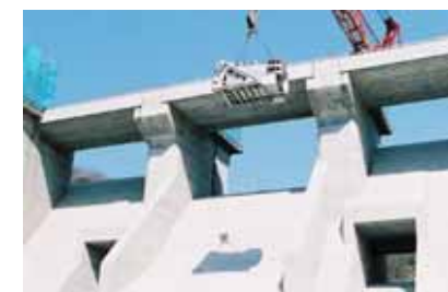
灰塚ダム建設工事の状況
