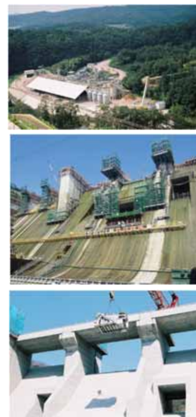
▲灰塚ダム建設工事の状況
