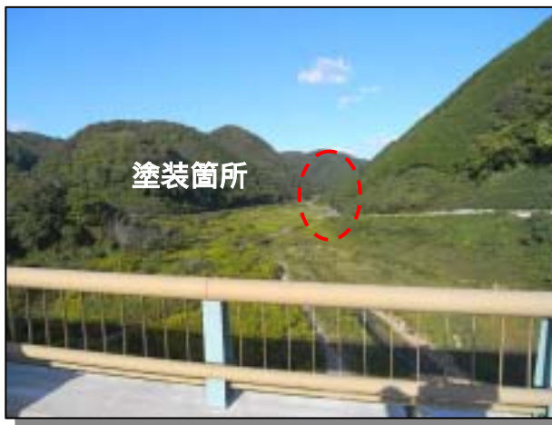
写真 塗装箇所の遠景
