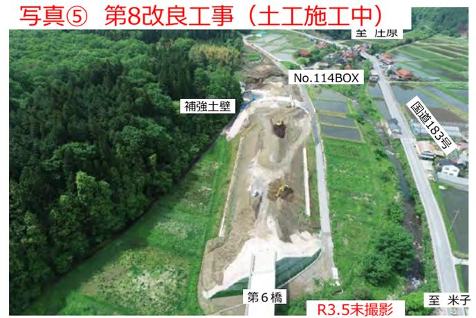
写真⑤ 第8改良工事（土工施工中）
