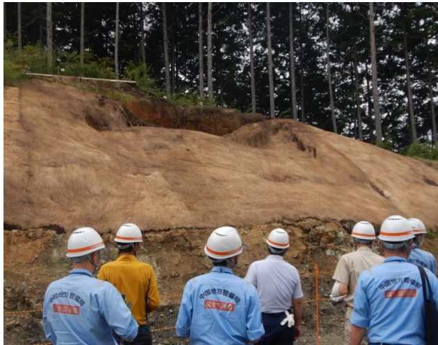
【写真③】現地確認の状況
