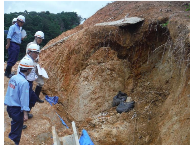
【写真②】現地確認の状況
