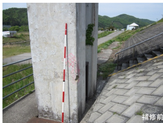
【馬洗川】 樋門門柱部のコンクリート劣化
