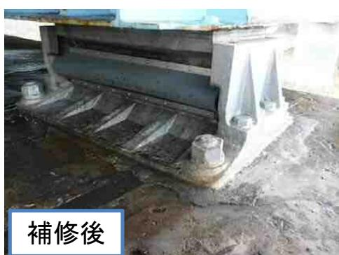
支承の補修（部品取替え、塗り替え）
