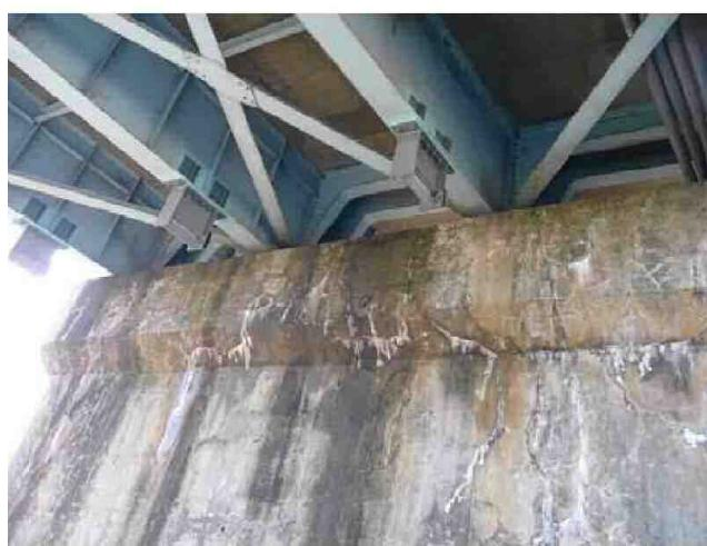
アルカリ骨材反応によるひびわれ
