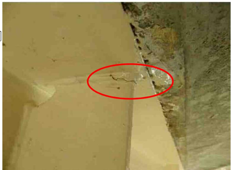
主桁の鋼部材に発生した疲労亀裂
