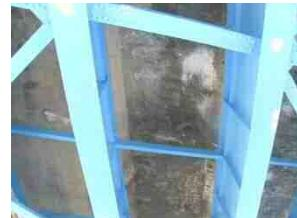
床版の疲労ひびわれ、漏水・遊離石灰等
