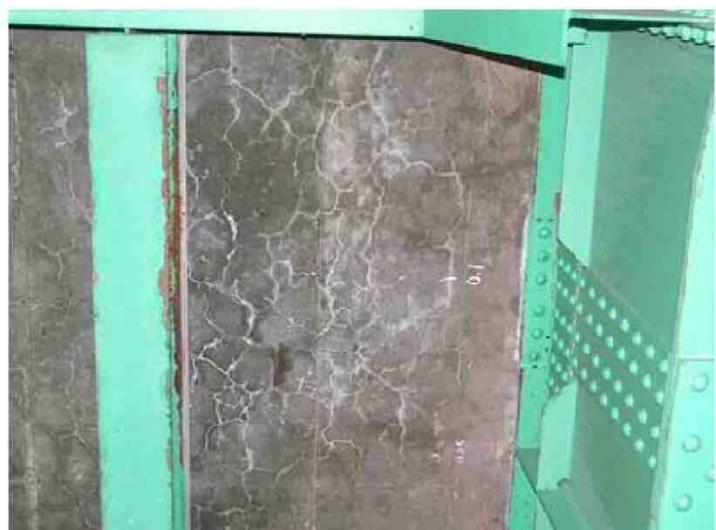
コンクリート床版に発生した疲労ひびわれ
