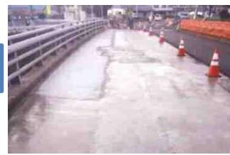
床版はつり、鉄筋防錆処理の後、超速硬コンクリートを打設
