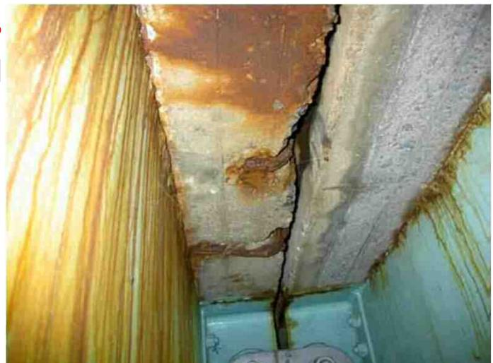
経年変化により床版のコンクリートが剥離
