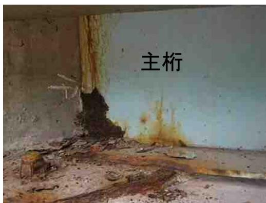
漏水により桁端部の主桁が腐食
