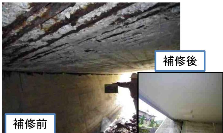
床版の鉄筋露出・腐食 床版の断面修復
