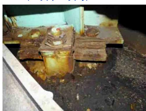
漏水により支承周りの鋼部材が腐食
