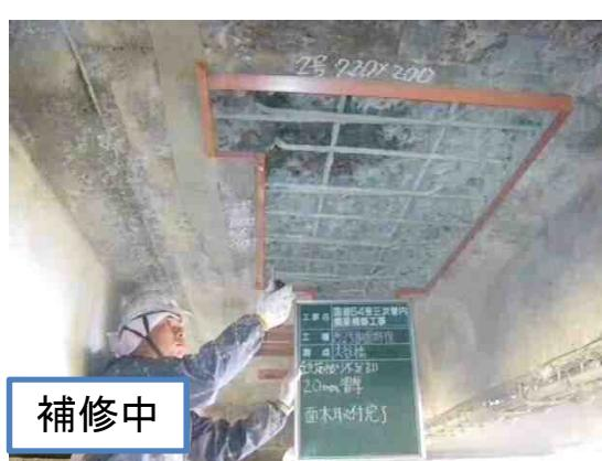
床版の鉄筋露出・腐食
