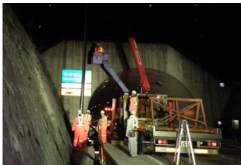
道路照明の補修
