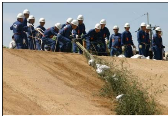
水防団による水防訓練 （竹流し工法）
