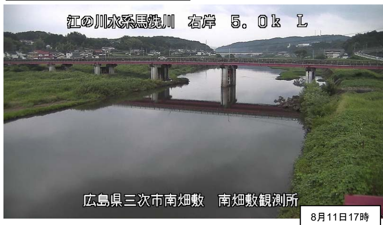
平常時の状況(南畑敷観測所付近)
