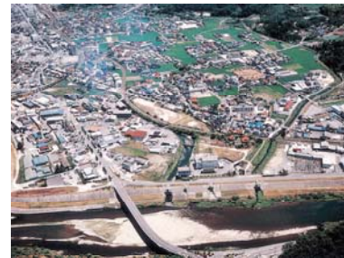
十日市排水ポンプ場(全景)
