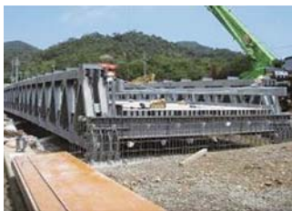
応急組立橋梁
