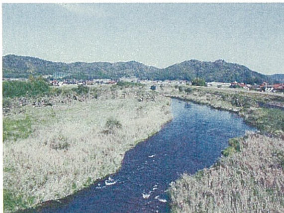
【整備前】新除橋から下流方向
