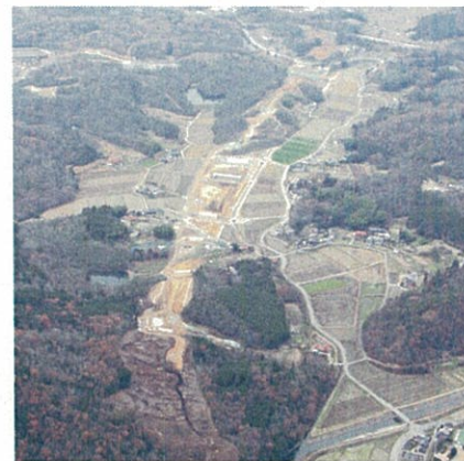
改良が進む三次市四拾貫町付近
