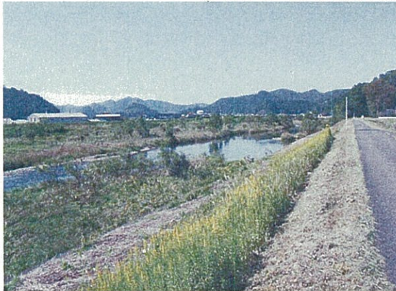
【整備前】左岸下流から上流方向
