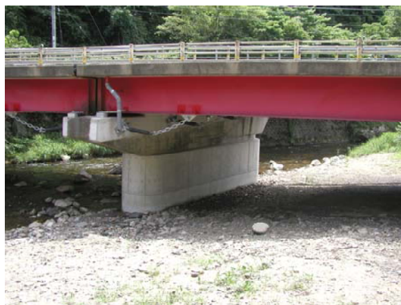
耐震補強例(新常盤橋)
