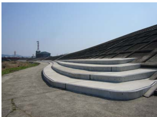
整備箇所全景
