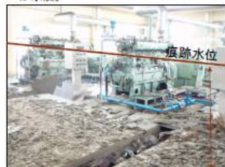
浜市排水機場(東松島市)
