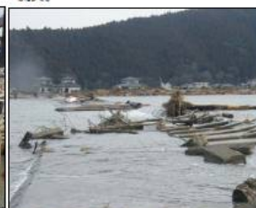
北上川右岸堤防(石巻市)
