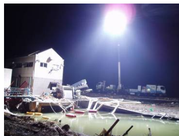
津波により排水機場が浸水。原動機等が水没。
