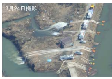
3月24日撮影 津波により排水路に瓦礫が散乱。一部は水路に埋没。
