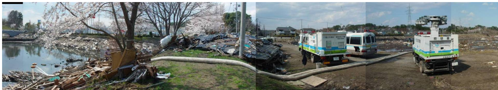
宮城県七ヶ浜町での排水作業
