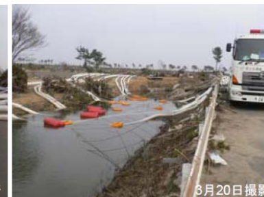
排水ポンプ車稼動状況(平成23年3月20日)
