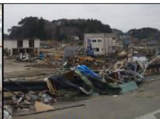
中下排水機場(東松島市)
