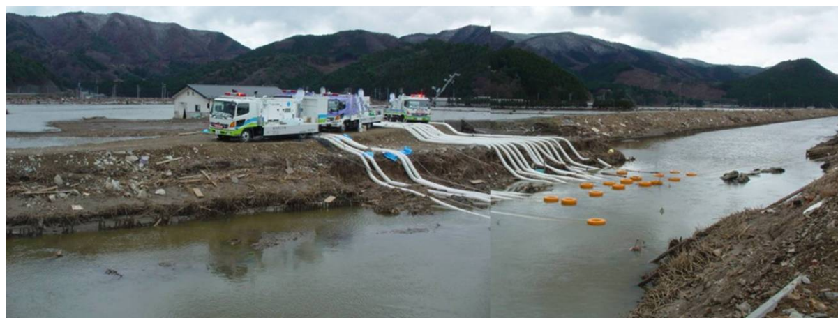
宮城県石巻市釜谷での排水作業
