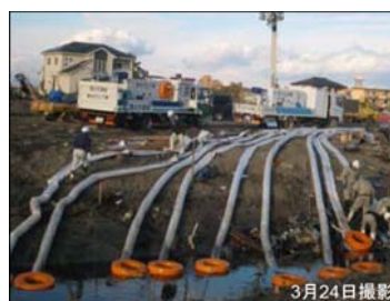
3月24日撮影 津波により排水路に瓦礫が散乱。一部は水路に埋没。
