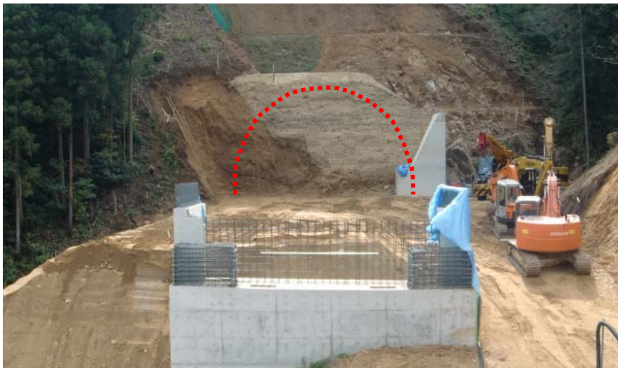
北側坑口の状況（ここから南側に向けて掘削を開始します。）
