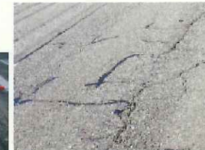
舗装のひび割れ
