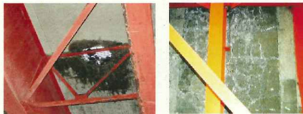
橋の裏面の様子(床版)
