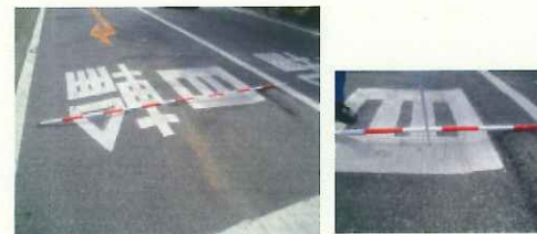
舗装のわだち掘れ
