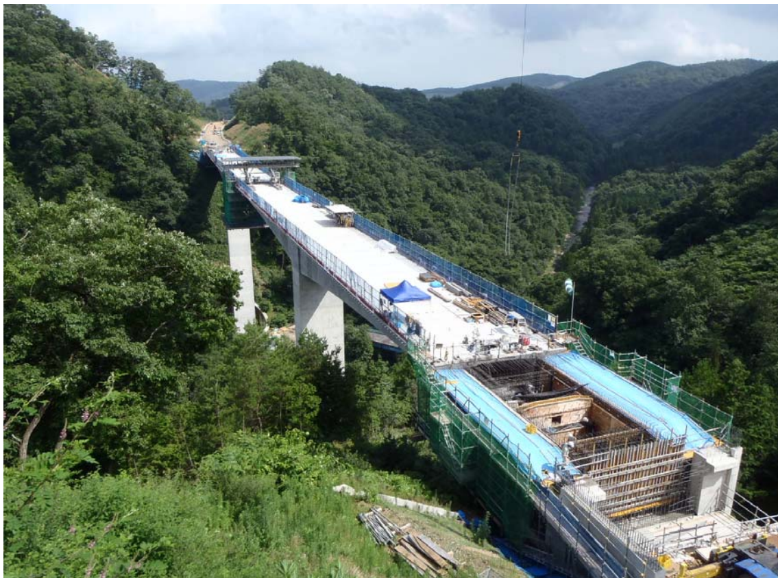
全景(松江方面より尾道方面を望む)
