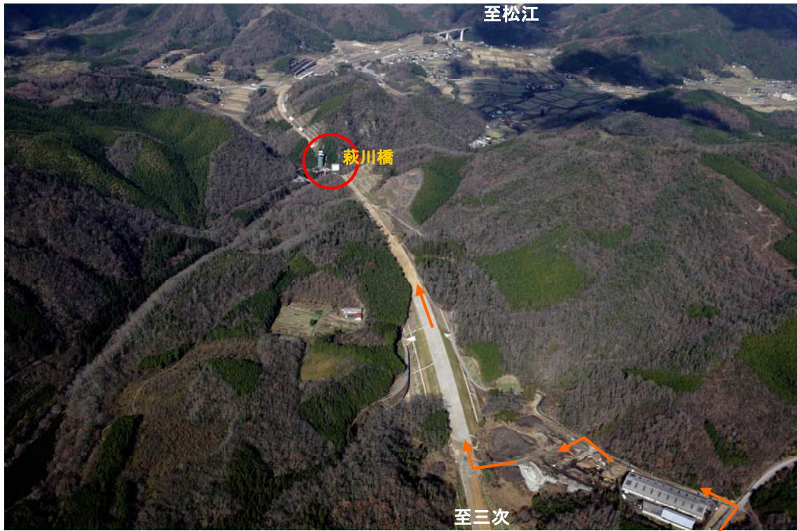
現地付近の状況
