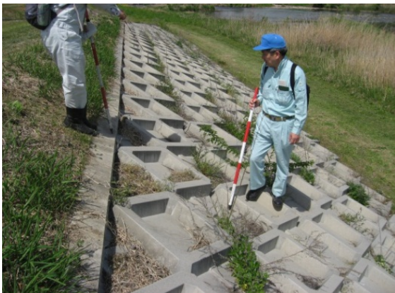
H25.5 出水期前の堤防点検状況
