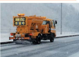
凍結防止剤の散布作業状況
