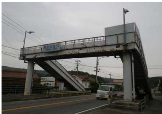
青河横断歩道橋補修前(撤去前)の状況
