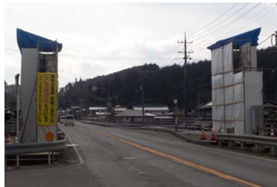
現在の状況(歩道橋撤去中)
