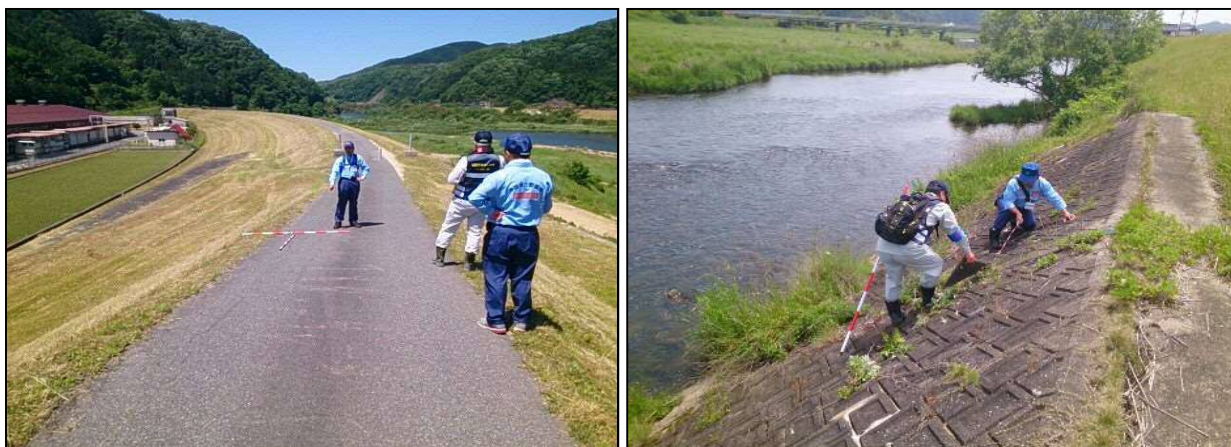
出水期前の堤防点検状況
