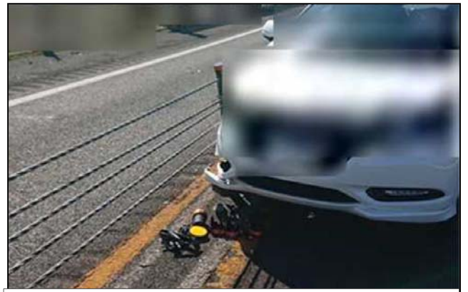
ワイヤロープにより、車線逸脱を防止
