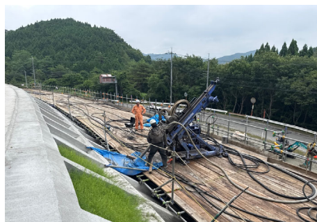
法面对策工の施工
