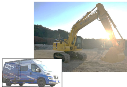
モビリティオフィスカーによる バックホウの遠隔操縦
