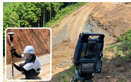
TS・GNSS 測量
