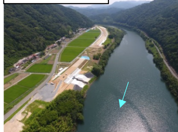
堤防整備状況
