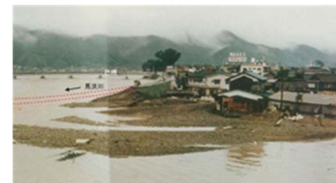
S47.7洪水 破堤地点(三次市十日市)
