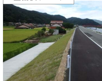
断面拡幅整備状況
