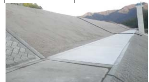
堤防(護岸)整備状況
