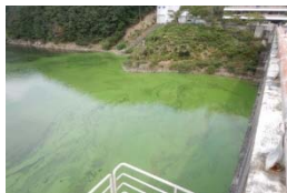
アオコの発生状況 (H28.9 土師ダム)
