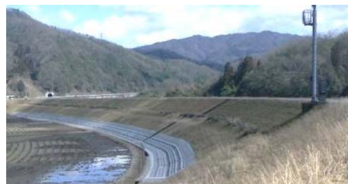
堤防裏法尻補強 (安芸高田市 梶矢地区)
