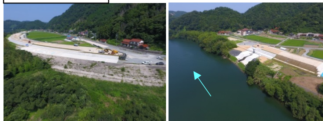
堤防整備状況
