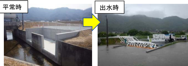
釜場(排水の水溜め・ポンプ設置場)整備状況 (安芸高田市 常友地区)
