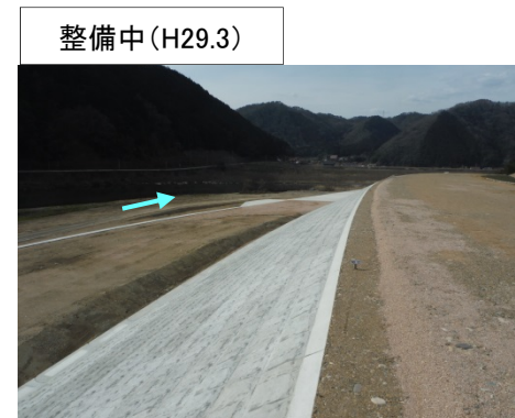
堤防整備状況
