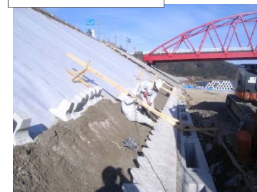
護岸・遮水シート整備状況
