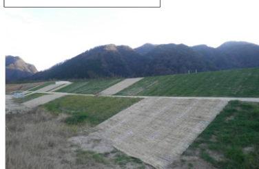
堤防整備状況(築堤)
