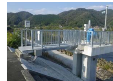
樋門の電動化 (上原樋門)
