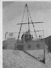
堤防点検（ボーリング調査）
