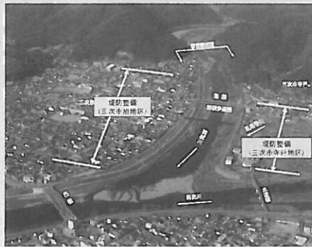
西城川堤防整備状況
