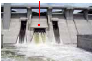
灰塚ダム中小洪水再現放流時の状況
