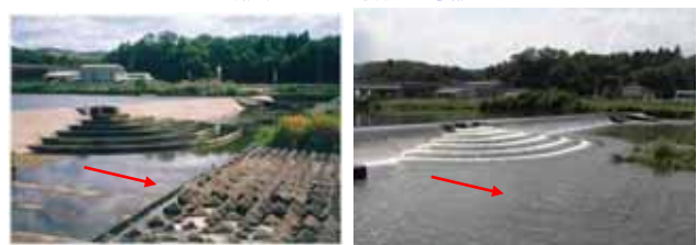
馬洗川 八次頭首工付近の状況
