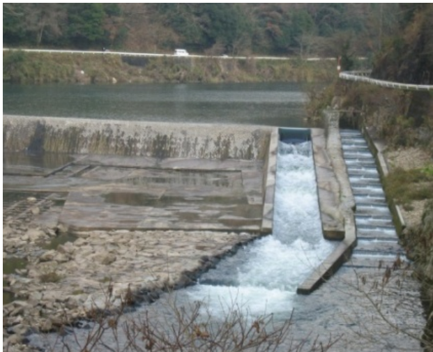
江の川取水堰の魚道
