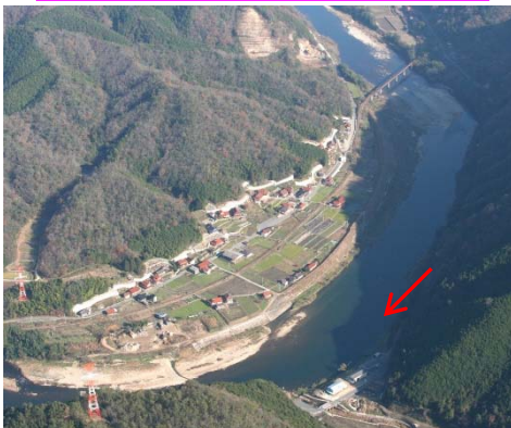
③ 124.2k~125.2k右岸(門田上流地区): 無堤部(整備必要箇所)
