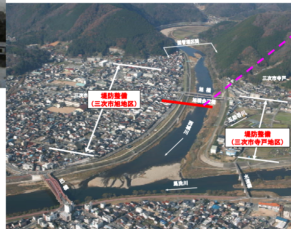
西城川堤防整備状況
