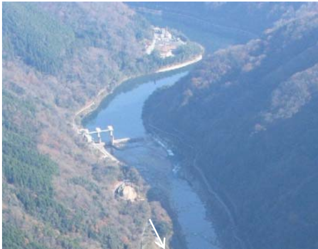
江の川取水堰の状況
