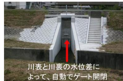
川表と川裏の水位差によって、自動でゲート開閉
