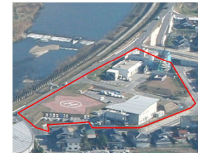
写真 1.2.5 河川防災ステーション
