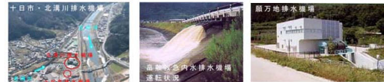
写真 1.2.2 江の川における排水施設
