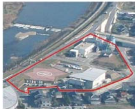
写真 1.2.5 河川防災ステーション
