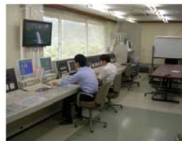
土師ダム操作室
