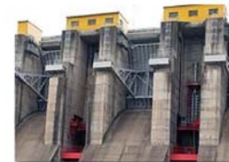
放流施設(土師ダム) 写真 5.2.5 既設ダムの施設状況
