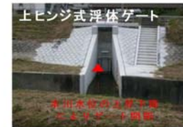
写真 5.2.4 樋門ゲートの自動化
