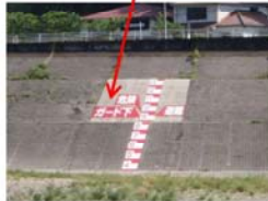
写真 5.2.6 避難経路を考慮した水位表示
