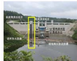
灰塚ダムにおける選択取水施設
