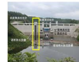
灰塚ダムにおける選択取水施設
