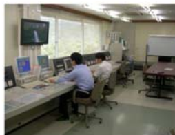
土師ダム操作室
