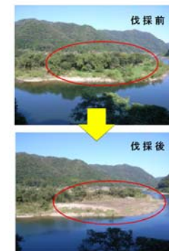
写真 2.4.1 河道内の樹木伐採
