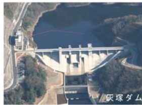
写真 2.4.4 既設ダム(国管理)
