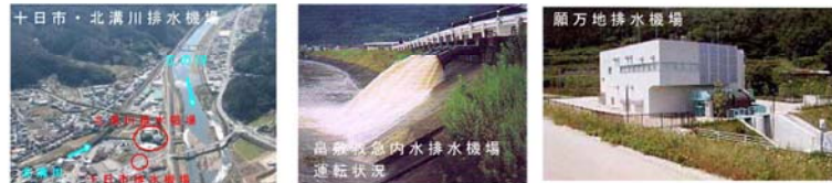
写真 1.2.2 江の川における排水施設
