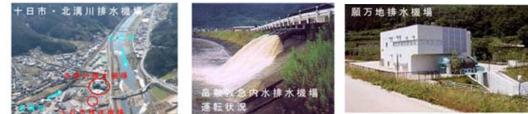
写真 1.2.2 江の川における排水施設
