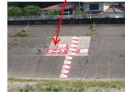
写真 5.2.6 避難経路を考慮した水位表示
