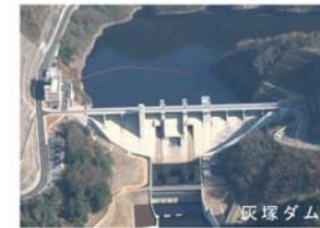
写真 2.4.4 既設ダム(国管理)
