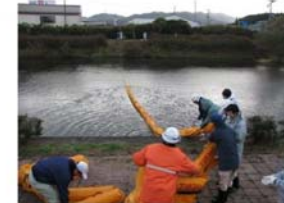
オイルフェンス設置訓練
