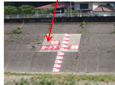
写真 5.2.6 避難経路を考慮した水位表示
