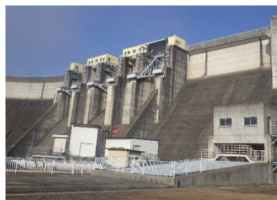
放流施設（土師ダム）
