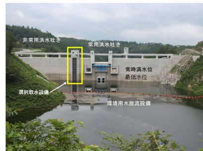
灰塚ダムにおける選択取水施設
