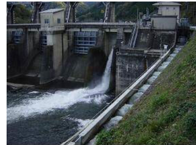
浜原ダムと魚道
