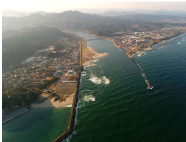
山地から扇状地を形成せずに日本海へ注ぐ下流部
