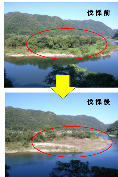
写真 2.4.1 河道内の樹木伐採
