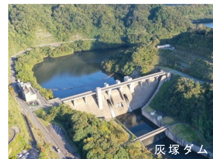
写真 2.4.4 既設ダム（国管理）
