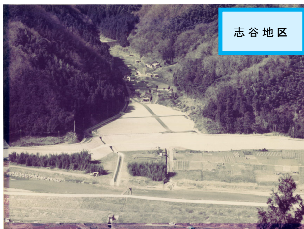
写真 1.2.1 特定河岸地水害対策事業
