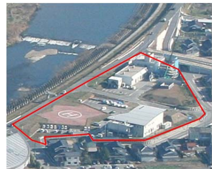
写真 1.2.5 河川防災ステーション
