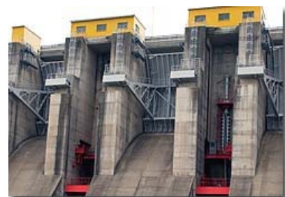
放流施設（土師ダム）
