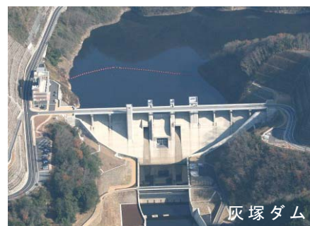
写真 2.4.4 既設ダム（国管理）
