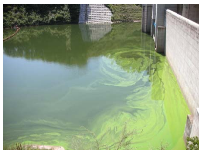
堤体上流部におけるアオコ発生状況
