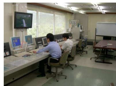
土師ダム 操作室
