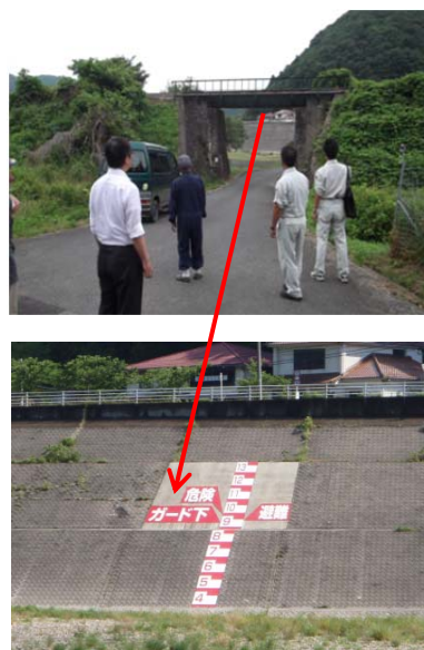
写真 5.2.6 避難経路を考慮した水位表示
