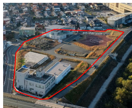
写真 1.2.5 河川防災ステーション
