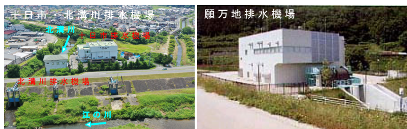
写真 1.2.2 江の川における排水施設
