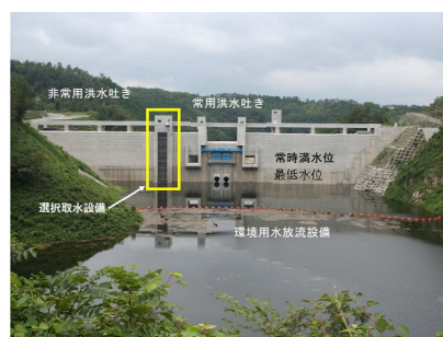
灰塚ダムにおける選択取水施設
