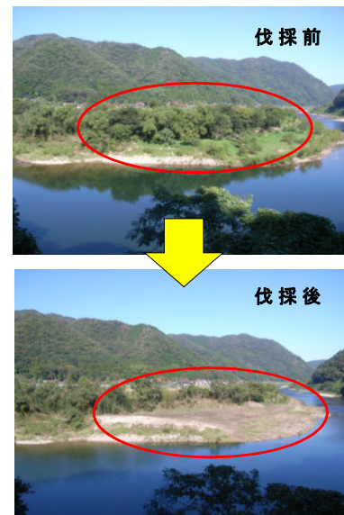
写真 2.4.1 河道内の樹木伐採
