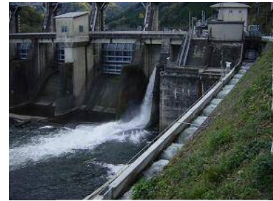
浜原ダムと魚道
