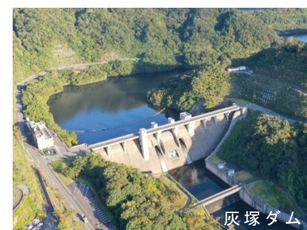
写真 2.4.4 既設ダム（国管理）
